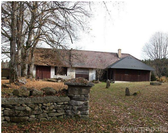
Das Wirtschaftsgebäude des alten Forsthauses wurde als einziges Haus verschont.
