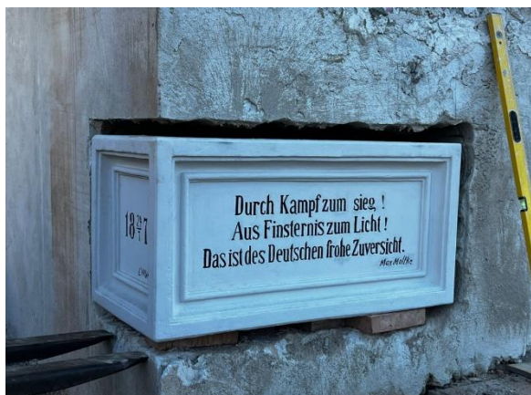
Nalezený základní kámen v době jeho instalování na nároží budovy v roce 2025. Nápis v překladu Jana Mareše zní: „Vítězit bojem, když ze tmy záře je, toť Němců buď radostná naděje!“ foto: Vladislav Benda
